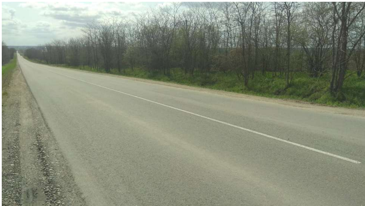
«Ремонт участка автомобильной дороги Новоалександровск-Красночервонный».
