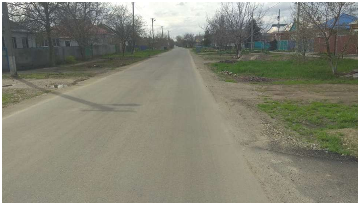
«Ремонт участка автомобильной дороги «улица Гагарина, город Новоалександровск».
